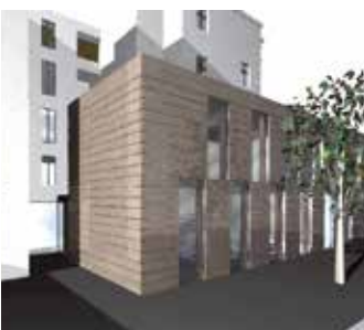
Der monolithisch wirkende Neubau ist in einem Abstand von circa zwei Metern vom Bestandsbau versetzt. In der Fuge, welche als Zugang dient, sitzt das gläserne Foyer.
