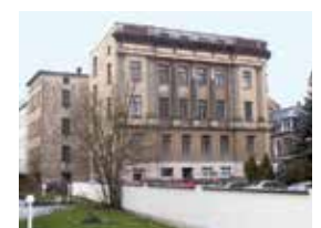
Abb.: Ansicht West und Nord
