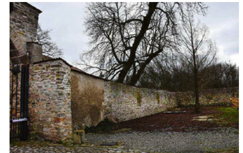
Entwurfsbereich innerhalb der Mauern: Wirtschaftsgebäude in den 1980er Jahren abgebrochen
