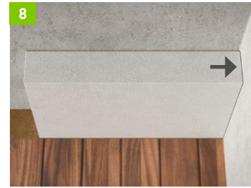
... und senkrecht zu den Mörtelstegen gegen die Ecke bzw. vorige Platte einschwimmen.
