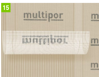
Armierungsgewebe auflegen. Die Bahnen mit ca. 10 cm Überlappung verlegen.
