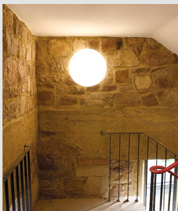
Alte Elemente blieben erhalten
