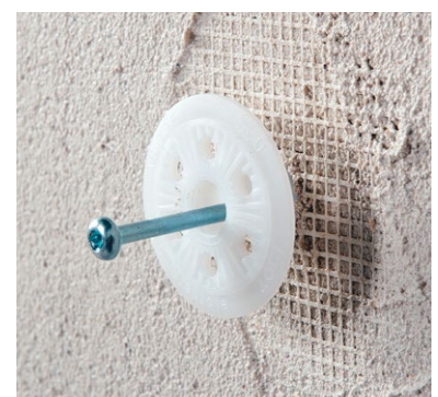
Setzen des Schraubdübels bei Fliesen
