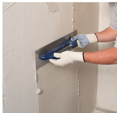
Aufziehen des Oberputzes
