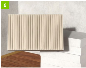
Auf Mineraldämmplatte vollflächig aufgetragener Leichtmörtel.
