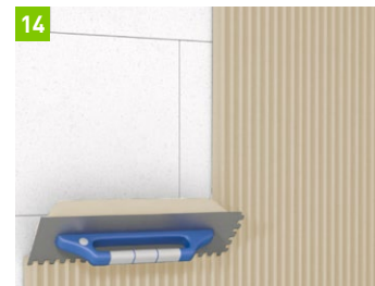
Leichtmörtel mit 12-mm- Zahntraufel (5 mm dick) auftragen.
