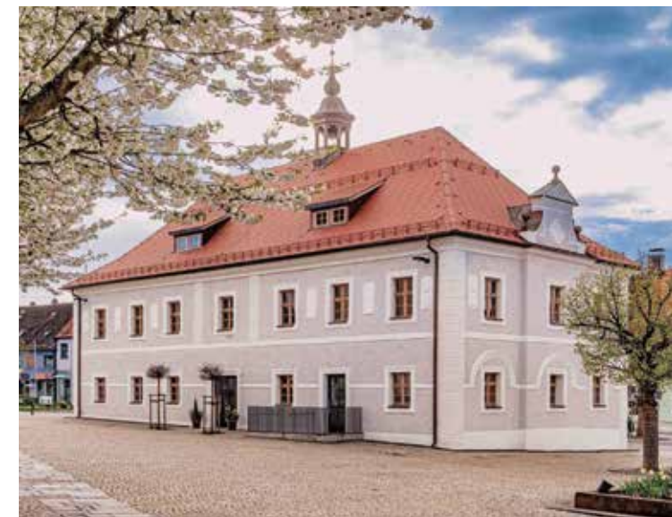
Rathaus Mitterteich Isolierglas mit mundgeblasenem Fensterglas restauro® Foto: HILGARTH ARCHITEKTEN / fotogen
