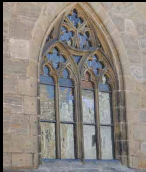
St. Martin, Amberg Mundgeblasenes Fensterglas im Maßwerk thermisch gehärtet; Rechteckscheiben als Verbundglas
