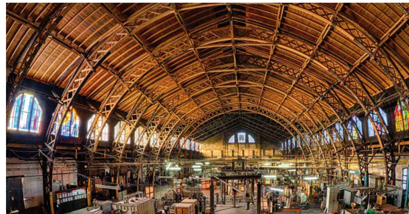
Blick in unsere 1906 erbaute historische Ofenhalle.
