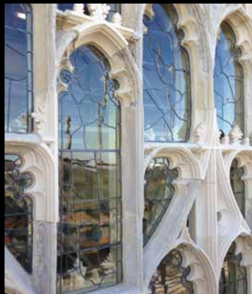
York Minster, Great East Window: Außenschutzverglasung aus restauro® UV-Schutzglas als Bleiverglasung
