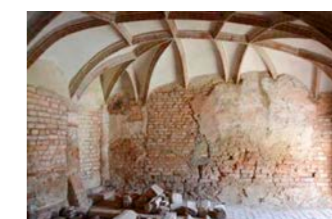
Netzgewölbe im Erdgeschoss
