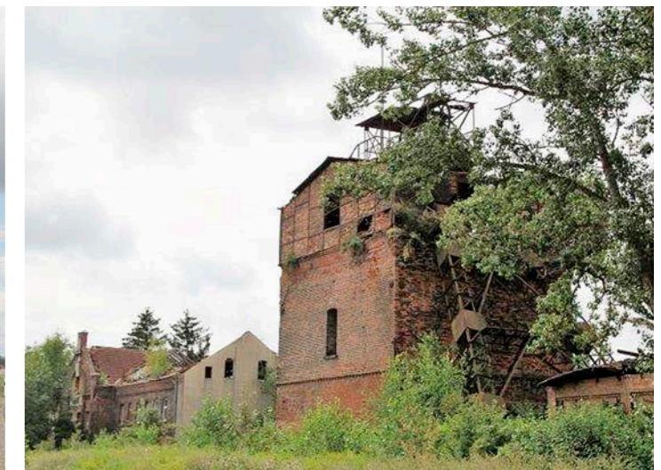
Funktionales Gebäudeensemble mit weitgehend erhaltener Fördertechnik
