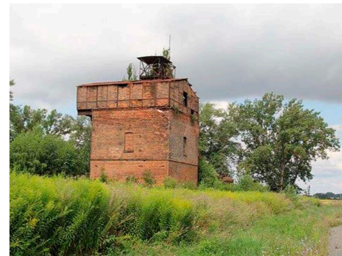
Förderschachtgebäude mit Strebenfördergerüst von 1915
