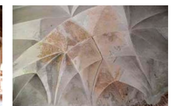
Zellengewölbe im Obergeschoss
