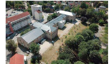
Luftaufnahme des Herzoglichen Marstalls mit Baufeld für die neue Remise
