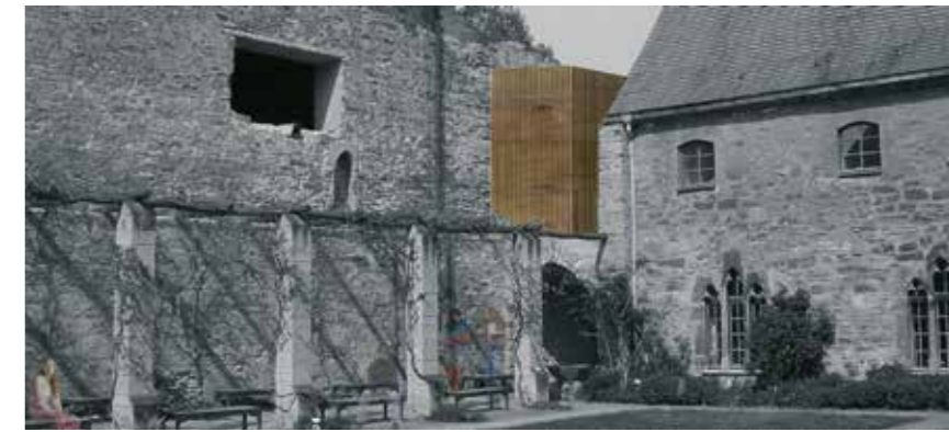
Ein Einschub aus Holz und Glas bildet die neue Übergangszone zwischen dem alten und neuen Seminarbereich.
