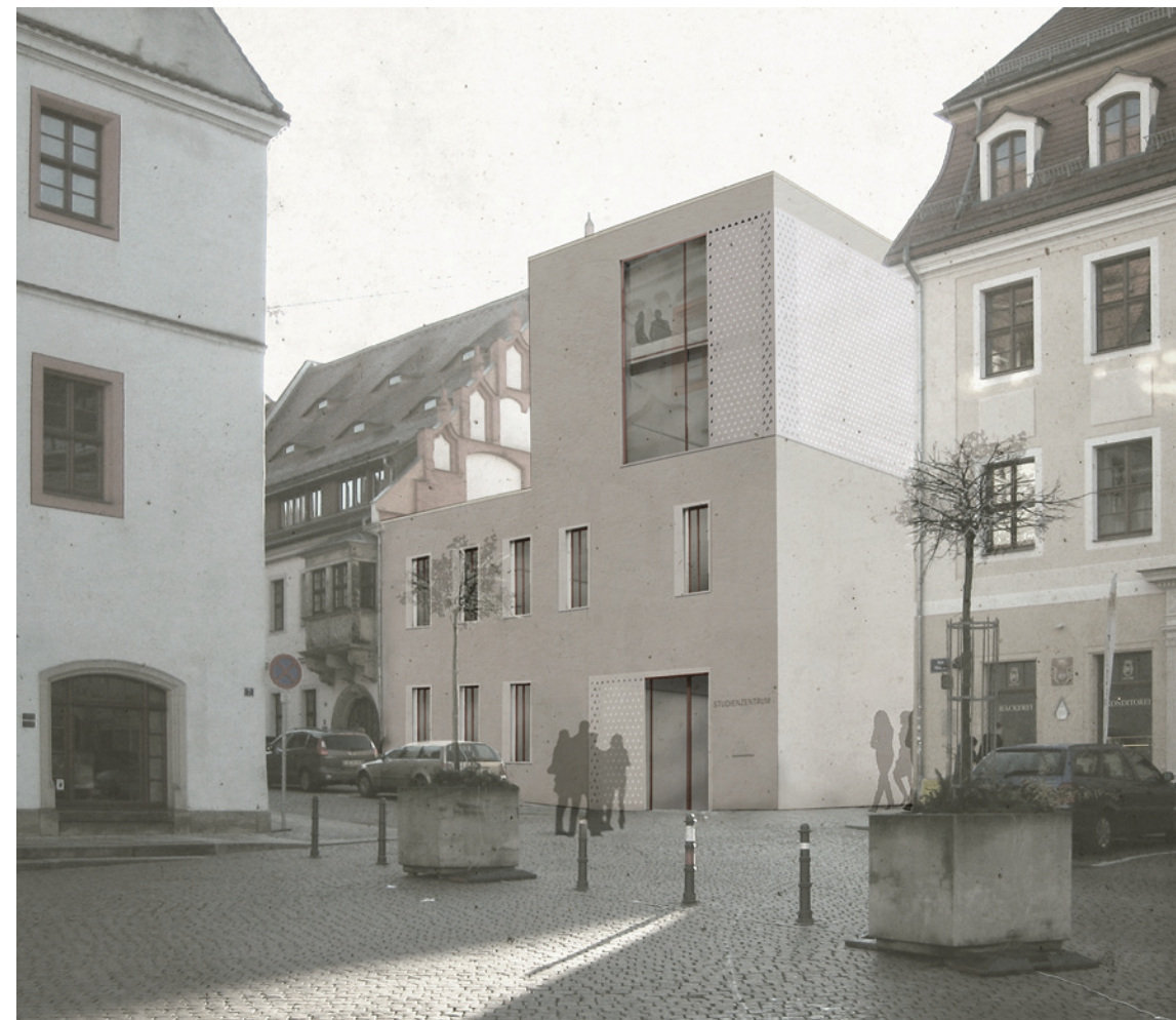
Blick vom Marktplatz auf die Schlossstraße 14, Ecke Frongasse
