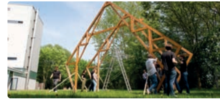
Aufbau der Konstruktion für den Workshop NB-LAB auf dem Campus der Hochschule Wismar
