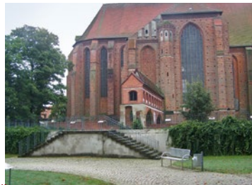
Brandenburg Bad Wilsnack Kellergeschoss des ehemaligen Herrenhauses
